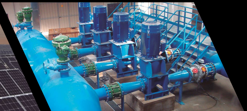
Estaciones de bombeo y EDAR Pump stations and WWTP
